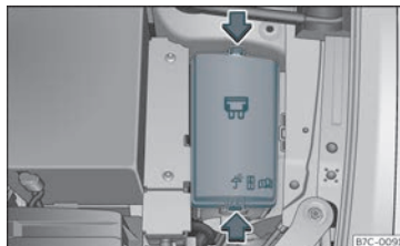
Fig. 55 I motorrummet: afdækning på sikringsboks
